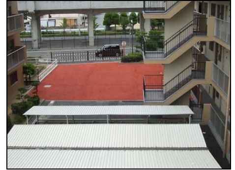
EF棟間ファイヤーレーン
