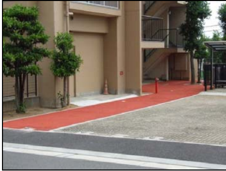
A棟ファイヤーレーン
