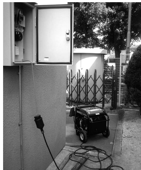
防災井戸電源を発電機に切り換えて給水訓練
