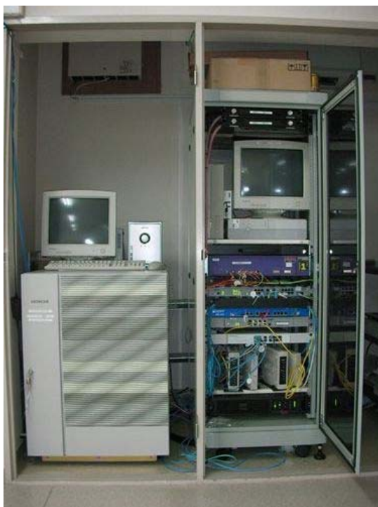
グリーンネット用サーバールーム
