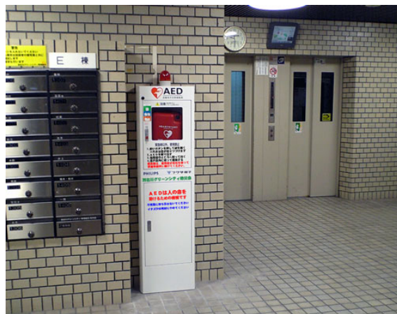
B・D・E棟1階エントランスに設置
