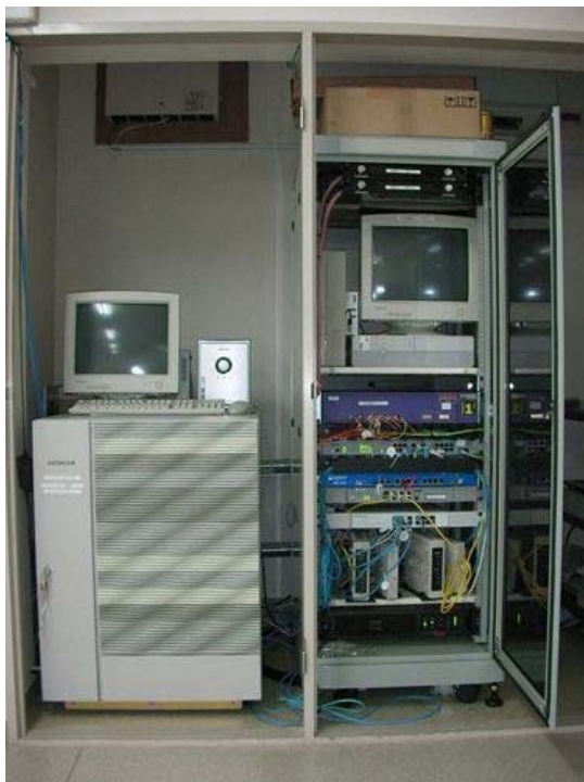
グリーンネット用サーバールーム
