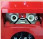
①受信機の「音響停止」を押し**受信機**の音を一旦止める。②受信機の「**地区音響一時停止**」を押し、地区音響ベルの鳴動を一定時間止める(一定時間後に再び鳴動)。③押された**発信機**の「強く押す」と書かれたプレートの上にある「火災報知機」と書かれた小窓を開け、中にある**リセットレバー(黒いM型の針金)**を下側に押す。カチャッと音が鳴り、押されたボタンが元に戻る。**発信機**の押しボタンが元に戻った後、**受信機**の小扉内にある「**復旧**」スイッチを押し**受信機**の火災表示状態を復旧させる。**発信機の押しボタンが元に戻っていないと、受信機の「復旧」スイッチを押しても受信機が復旧できないので注意!**
