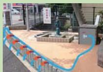
多くの人が水を必要とする場合、A棟ポンプ室内にある非常用給水設備(蛇口8個付連結パイプ)を接続できる
